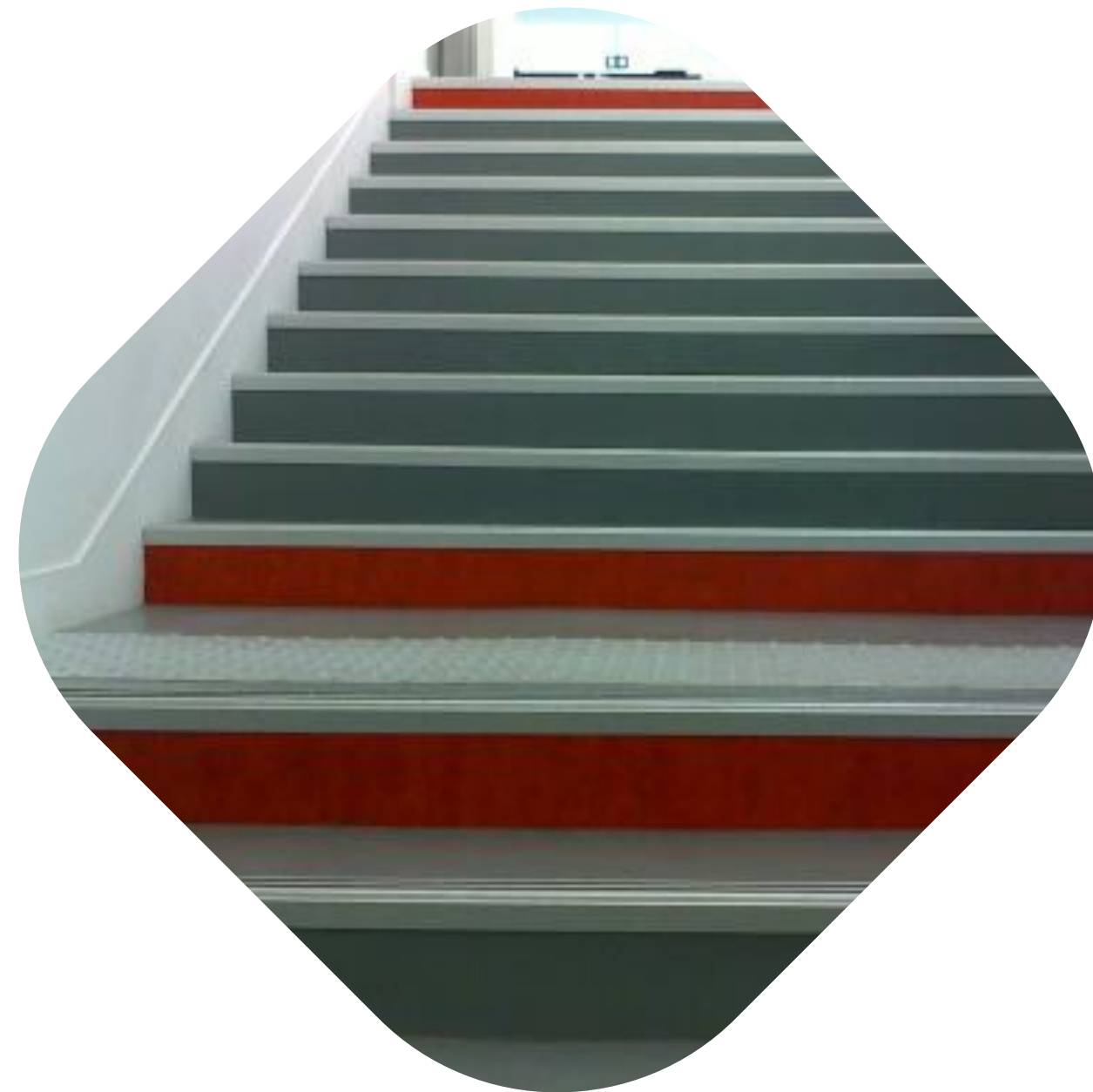
Mains courantes, repères visuels et podotactiles
